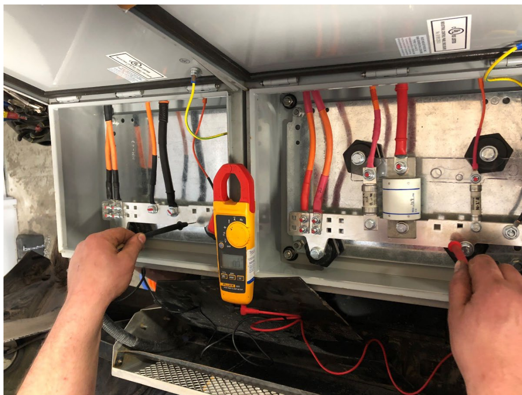
Figure 6 - Connexion du voltmètre
